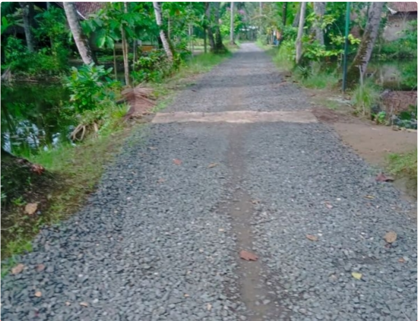
Hasil pekerjaan PSU peningkatan jalan lingkungan Kampung Wanasari Desa Sukatani
