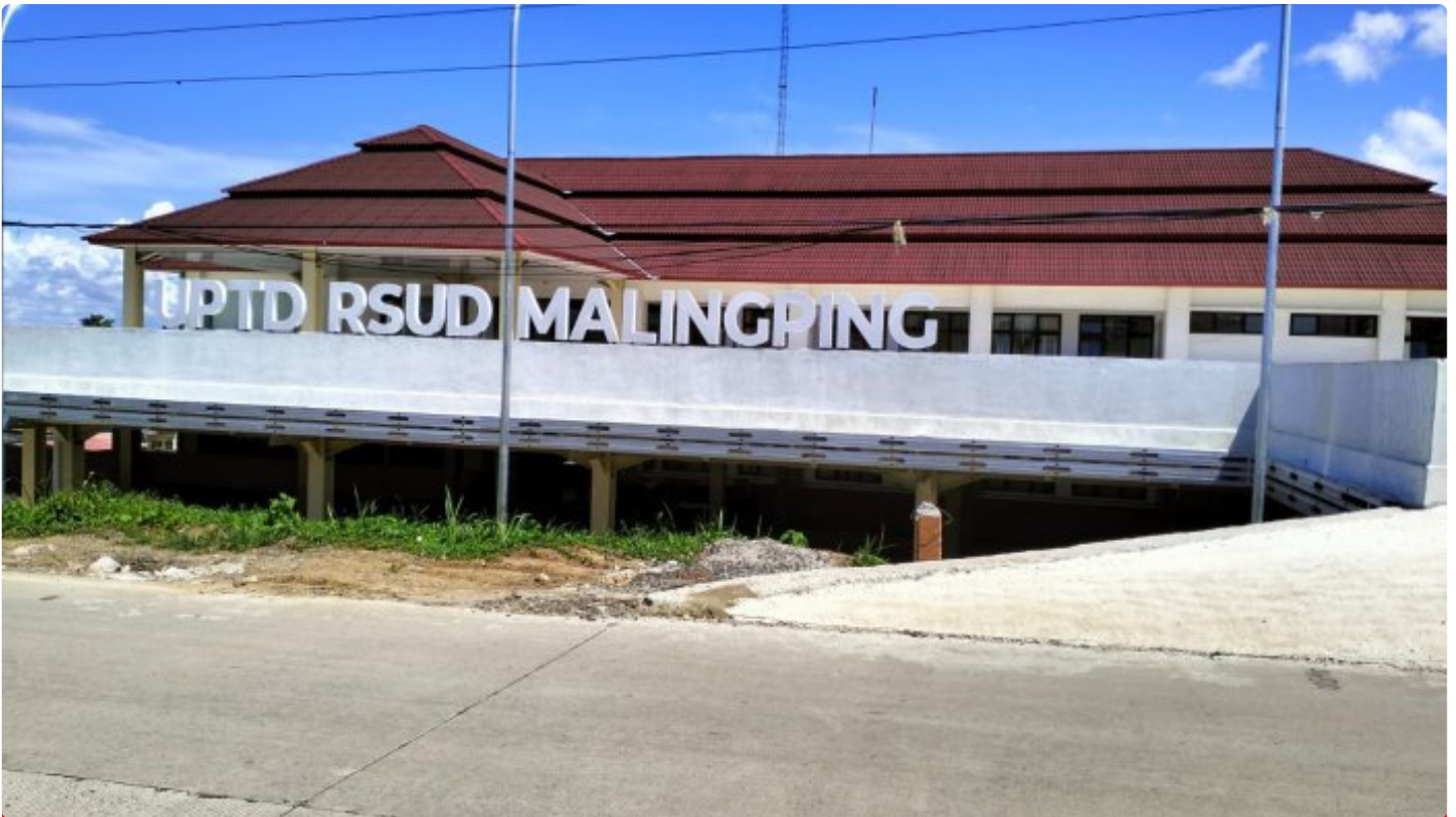
Gedung parkir RSUD Malingping yang sudah diresmikan
